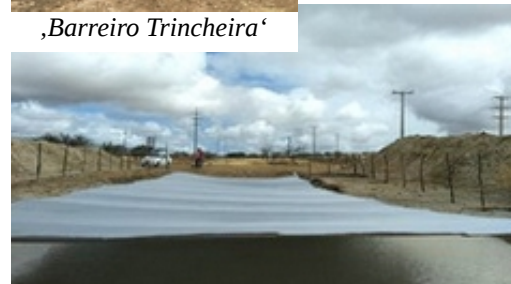
Abgedecktes Wasserbecken ‚Barreiro Trincheira‘
