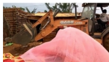
Bagger zerstörten die Häuser
