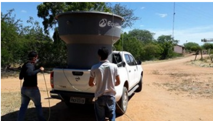
Irpaa-Mitarbeiter bringen die Materialien zum Bau der Anlage in die Landgemeinde
